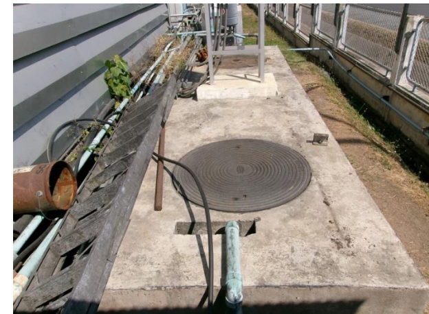
บ่อพักน้ำทิ้ง (ก่อนระบายไปยัง Sump pit 4)
