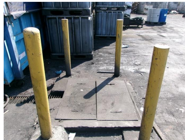
รูปที่ 2-26 บ่อดักน้ำมันขนาด 1.5 ลูกบาศก์เมตร
